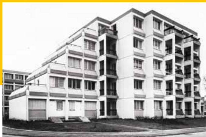
1972-74 – Nogent-sur-Oise – Procédé Variel – Architecte : G. Noël – 202 logements Hlm en 3 tranches – Modules tridimensionnels industrialisés béton.
