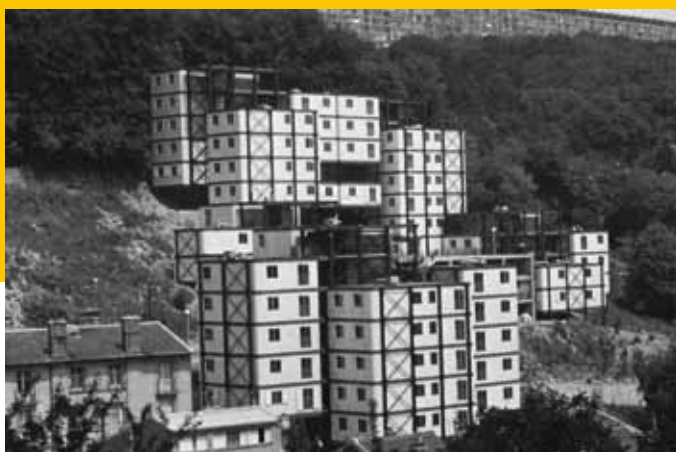
1973 – Nancy, rue de la Colline – Procédé Gamma – Architecte : Pariset – Projet mentionné au PAN – Procédé constructif : structure métallique.
