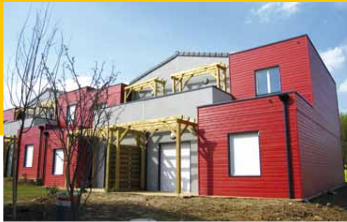
2012 – Vert-Saint-Denis – CQFD - Architecte : François Pélegrin – Éléments tridimensionnels préfabriqués en usine par Béneteau.
